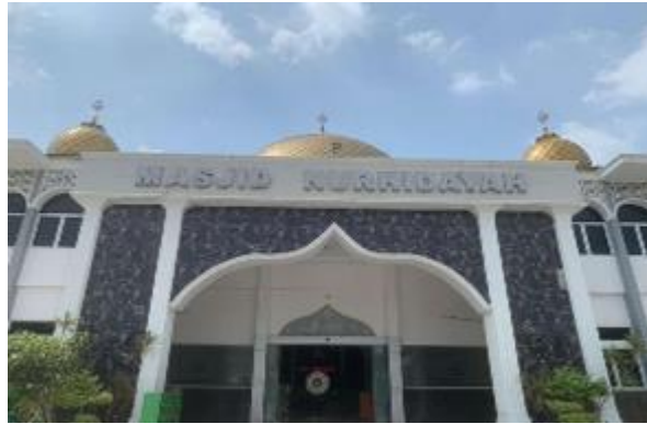
Gambar 1. Tampak Depan Masjid Besar NurHidayah - Jalan Demang lebar Daun Palembang
